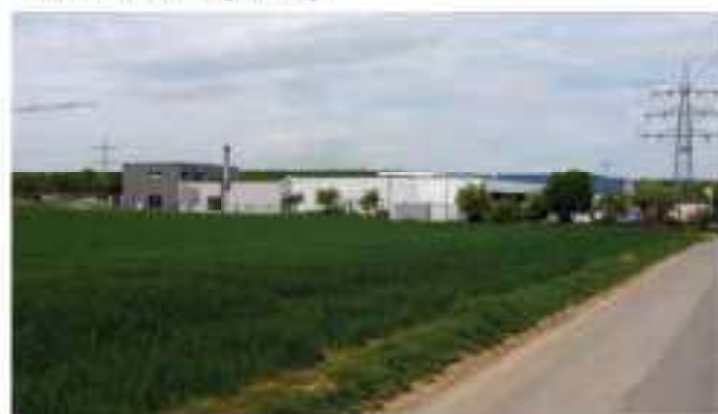
4 Blick in Richtung Norden zum GE Gröninger Weg
