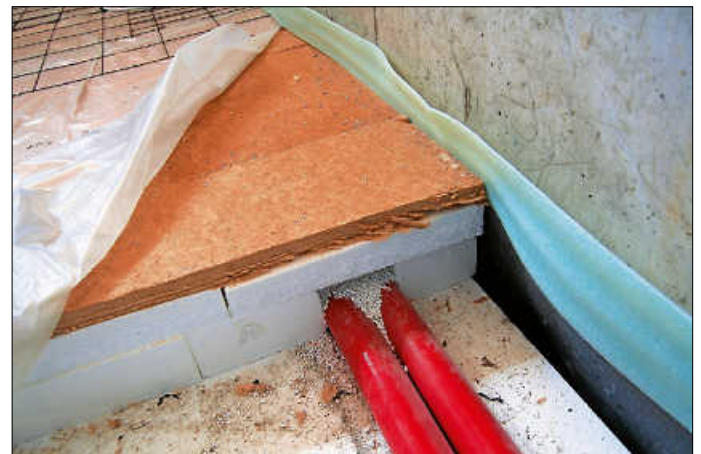
Praktische Schüttdämmung für Rohrleitungen | KEA
