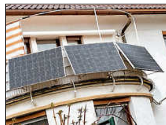
Steckersolargeräte ermöglichen auch Personen in Mietwohnungen eigenen Strom zu produzieren
