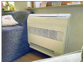
Sogenannte Klimasplitgeräte können neben dem Kühlen auch zum Heizen eingesetzt werden
