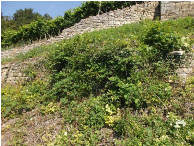
Abbildung 5 Abschnitt der Kategorie TM Funktionserfüllung mit Vegetation überwachsen
